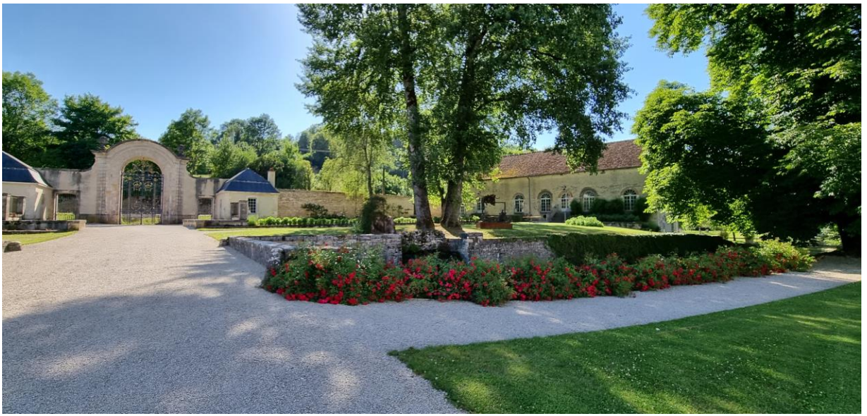
Vue sur la grille d'honneur et le moulin de l'abbaye © abbaye d'Auberive
